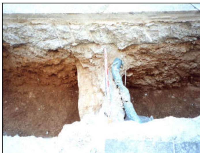
Foto 16: Detall del mur UE 209.
