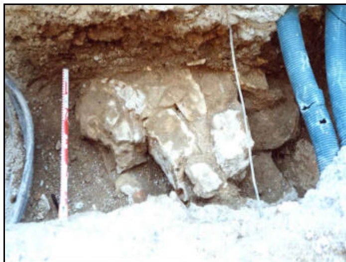
Foto 14: Detall del mur UE 208.
